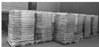
Les ossatures supports sont déchargées au transpalette ou manuscopique. Une protection type plaque OSB sera posée sur le revêtement d'étanchéité afin de ne pas risquer de l'endommager.
