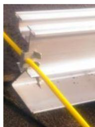
La mise à la terre de chaque module est réalisée au niveau du cadre du module sur le rail à l'aide d'un câble vert/jaune de section 6 mm<sup>2</sup>, de cosses à œil en cuivre, de rondelles bimétal cuivre/aluminium et de vis auto perceuses.
